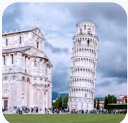
Außergewöhnliche Bauwerke Seite 6
